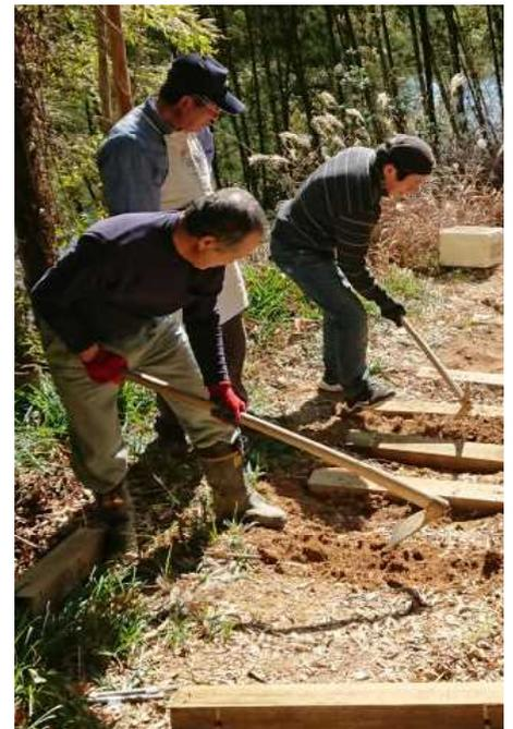
2月6日(土)防虫防腐杭で階段を整備
